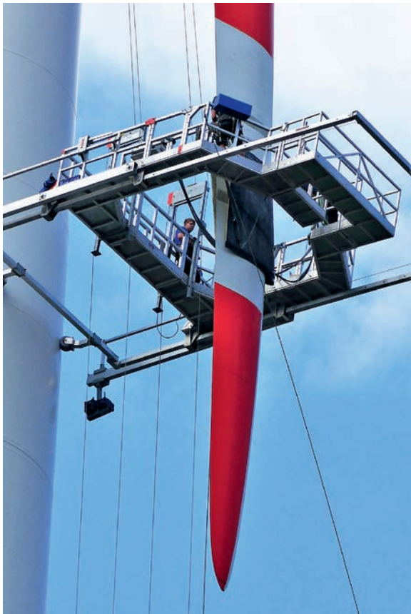
An einem Rotorblatt der Windenergieanlage in Eggebek wurde der aerodynamische Handschuh befestigt.
