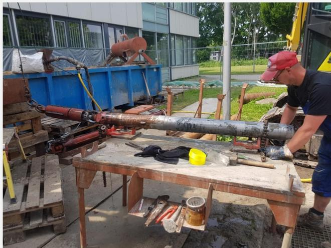
Abbildung 7: Sicherung des Rammkernrohrs zur Entnahme des Liners
