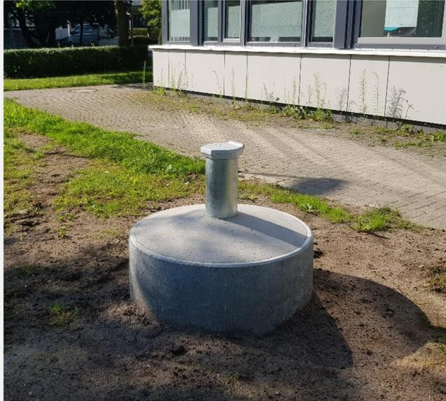
Abbildung 12: Obertägiger Ausbau Grundwassermessstelle CAU 3/21
