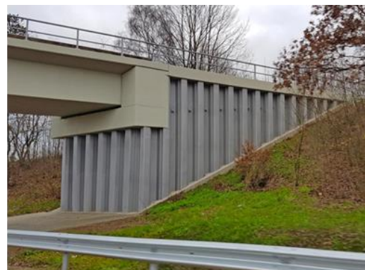
Bild 4.23 Dimensionierung eines Spundwandwiderlagers einer Straßenbrücke links: Plot aus Programm GGU-RETAIN rechts: ©Tim Zinke, 2019
