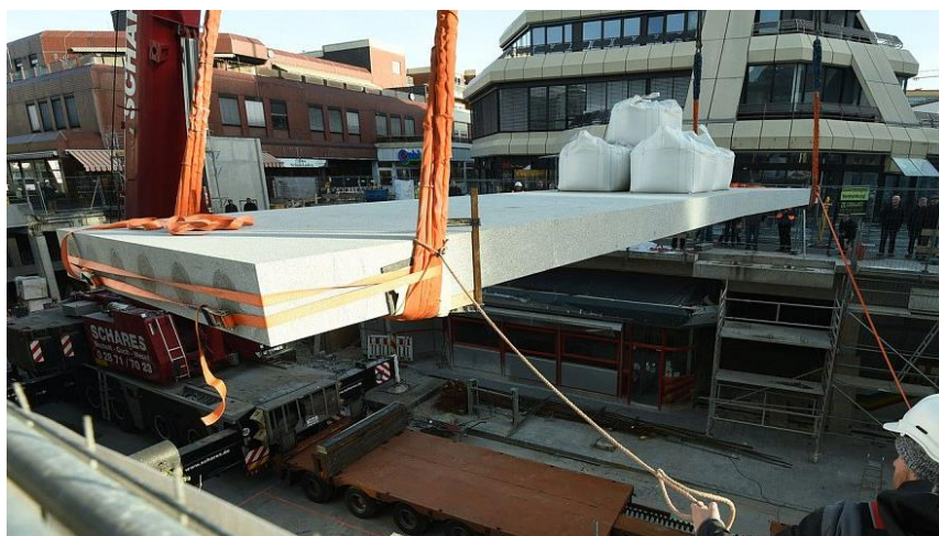
Bild 5.9 Einheben der Natursteinbrücke in der Königsstraße in Paderborn (Bild: © Marc Köppelmann)
