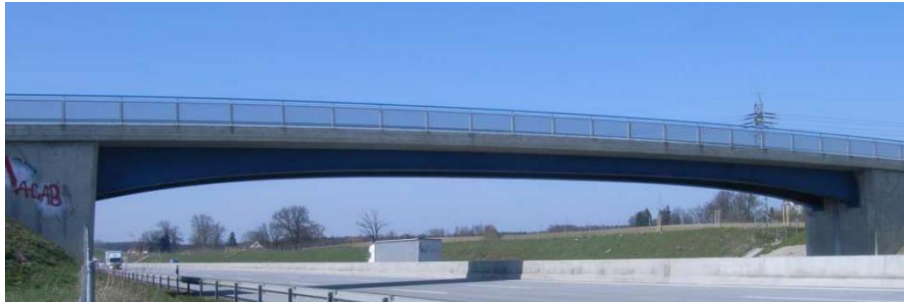
Bild 4.21 Eine integrale Verbundbrücke über 6-spurige Autobahn A8-West
