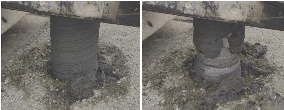
Abb. 5.40: Am Vortreibrohr haftende Kleischicht beim Herausziehvorgang
