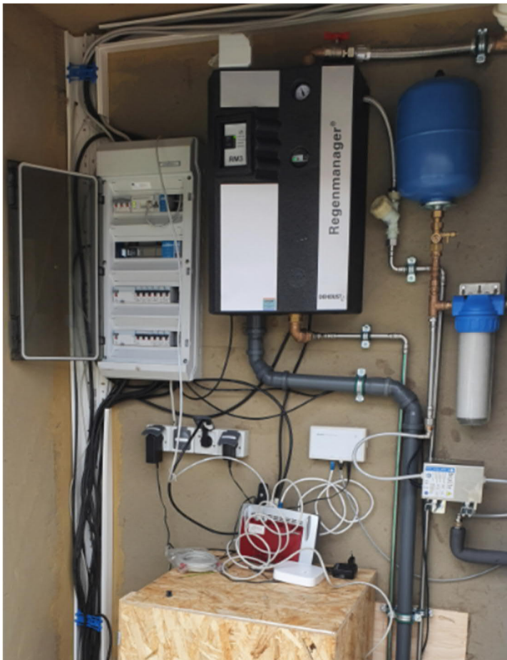
Abbildung 12: Einrichtung Monitoring mit Schnittstellen-Modulen und WLAN-Router
