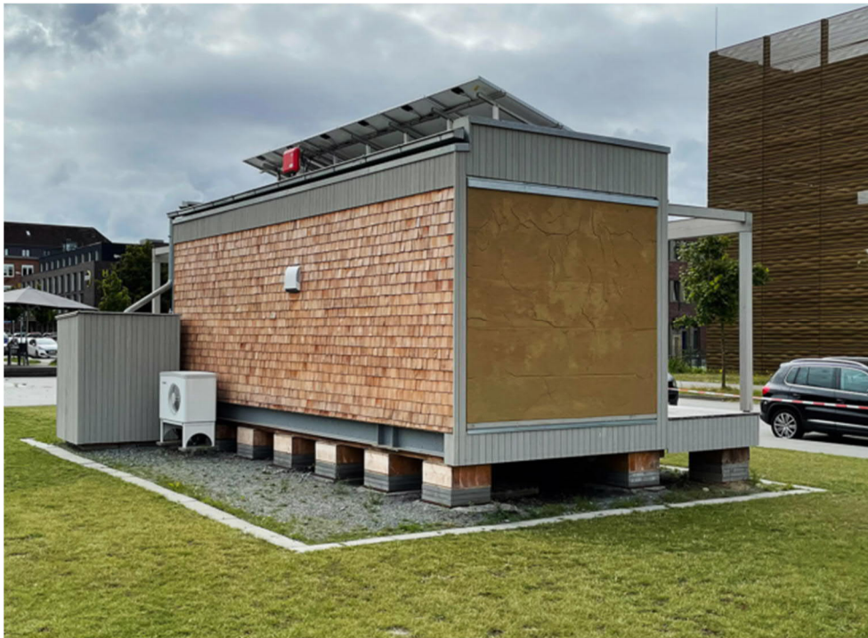
Abbildung 4: Außenansicht Rückseite nach Fertigstellung, Außeneinheit Wärmepumpe und PV-Anlage (Flachdach), Montage Wechselrichter unter PV-Modulen
